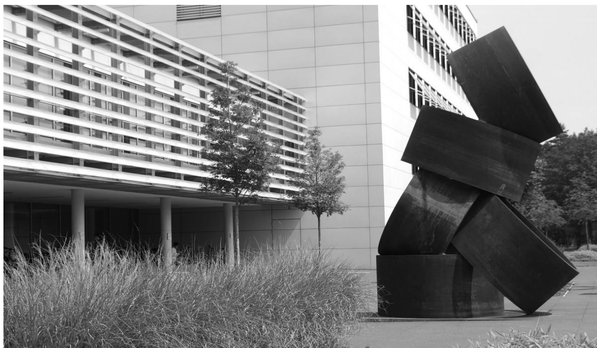
Eingangsbereich des Departments Mathematik, Cauerstraße 11
